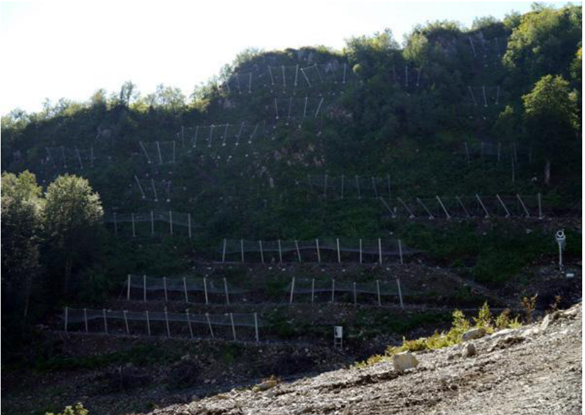
სურ.10.3. ზვავის შემაკავებელი პლასტმასის ბადე
