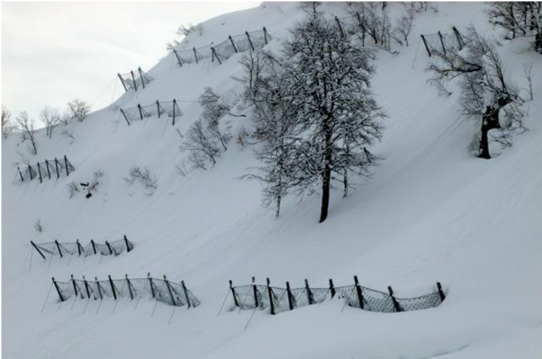
სურ. 10.4. ზვავის შემაკავებელი ალუმინის ბადე
